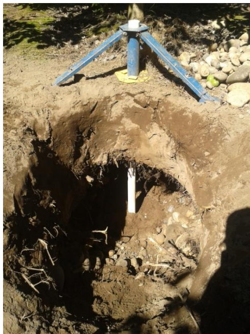
Foto 1. Tubo de acceso instalado por calicata. Suelo pedregoso bajo los 50 cm
